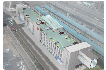
성균관대역 환승주차장 신축공사 [경기도 수원시]
