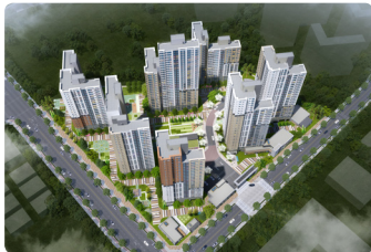
하남감일 B4블럭 신축공사 [동부건설]
