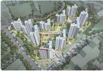
용인 영덕 기업형 임대주택 신축공사 [HMG]
