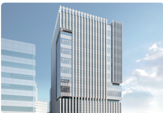
성수동 페코텍사옥 신축공사 [금호건설]
