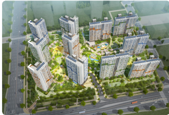
평택고덕A7블럭 신축공사 [한신공영]
